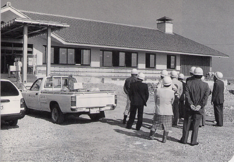
供用開始が近い入善浄化センター
