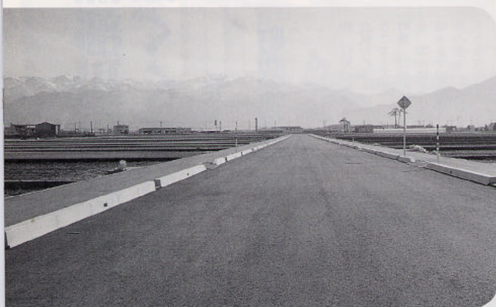
8号バイパスと8号線を結ぶ幹線道路
