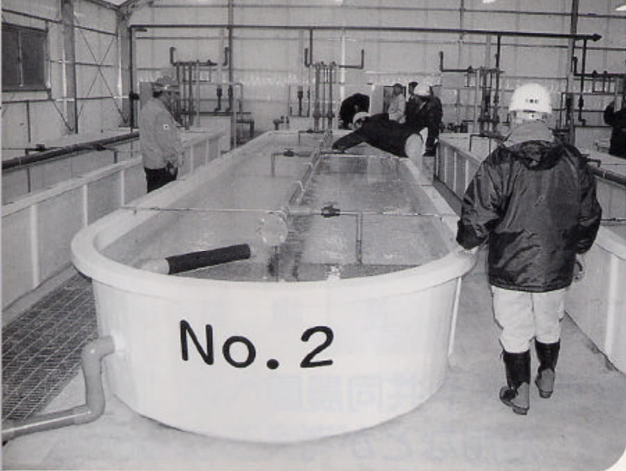
完成した深層水蓄養施設
