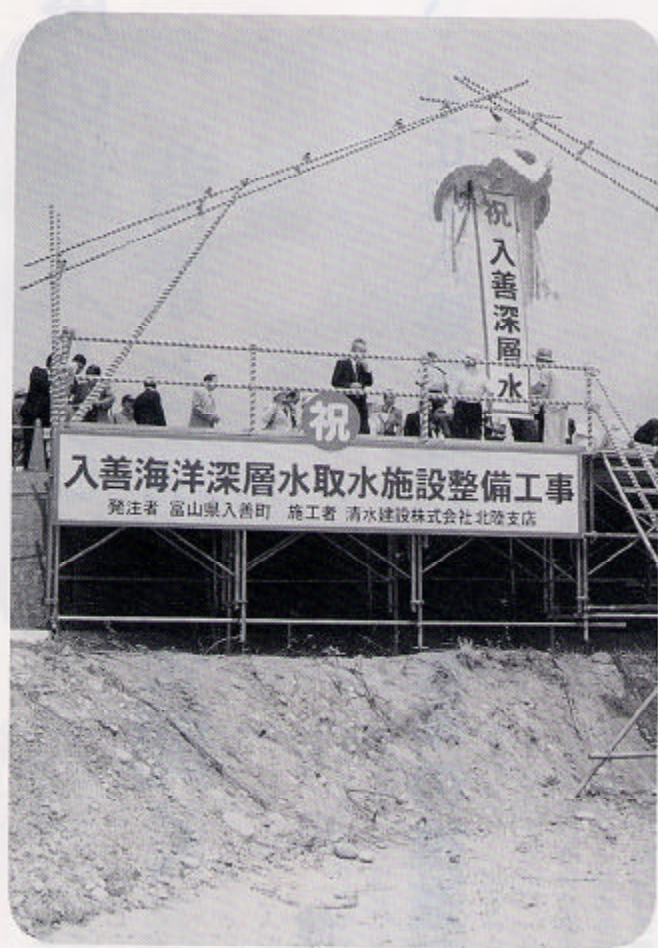
深層水取水管敷設式
