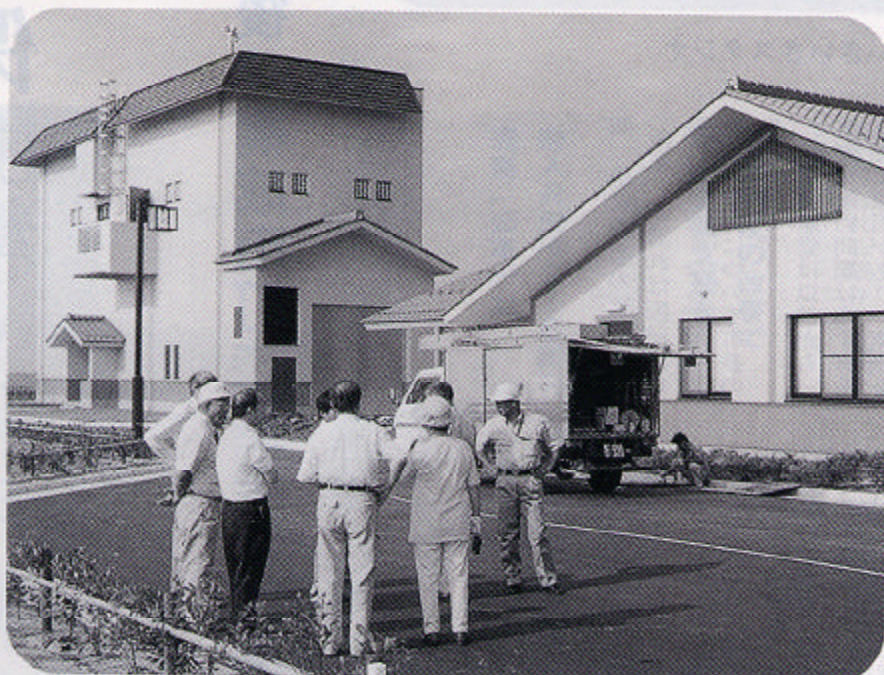
完成した入善浄化センター
