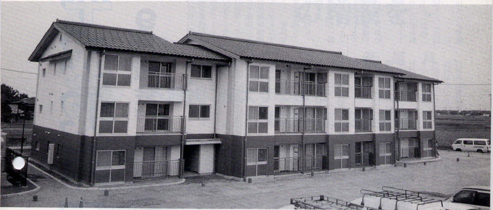
第一期工事が完成した東町町営住宅
