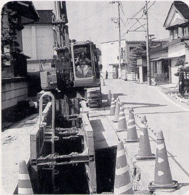
進行中の下水道工事
