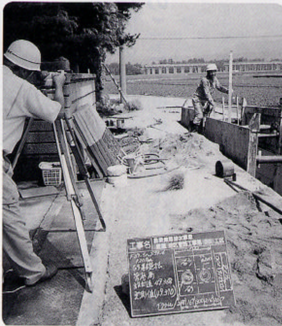
着々と進む下水道工事
