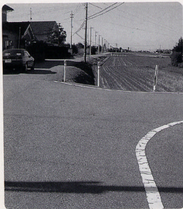
工事が中断した危険な幹線道路
