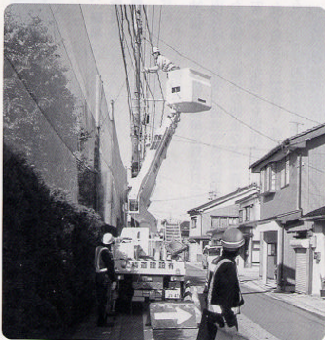
始まったケーブルテレビの工事
