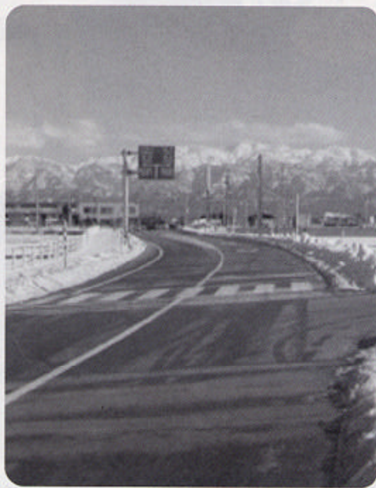
整備が進む平曾川国道線
