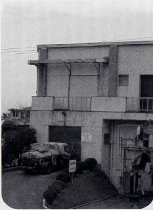
改修が急がれる中部清掃センター
