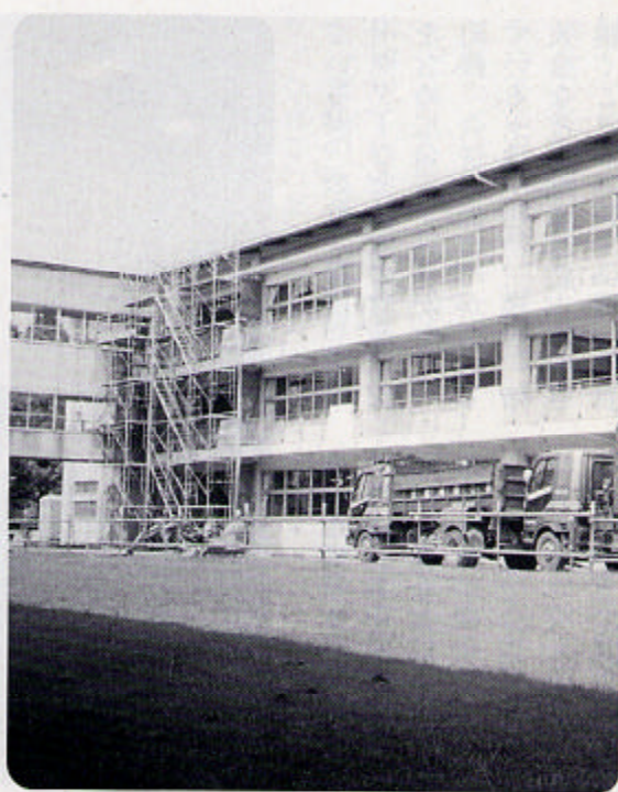
入善西中学校の耐震工事
