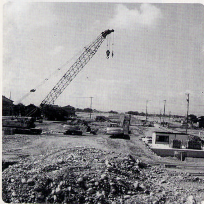
国道8号線バイパス工事
