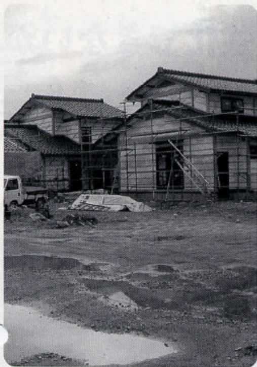
建設が進む東町町営住宅
