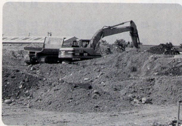
造成が進む企業設置予定地
