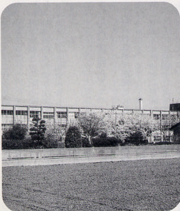
耐震補強工事予定の入善西中
