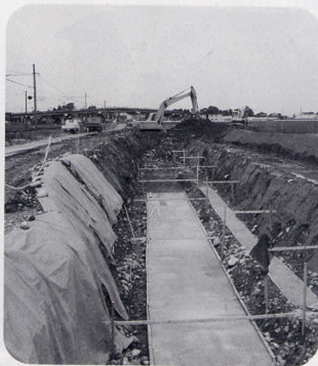
(株)サンリッツ周辺道路の整備工事
