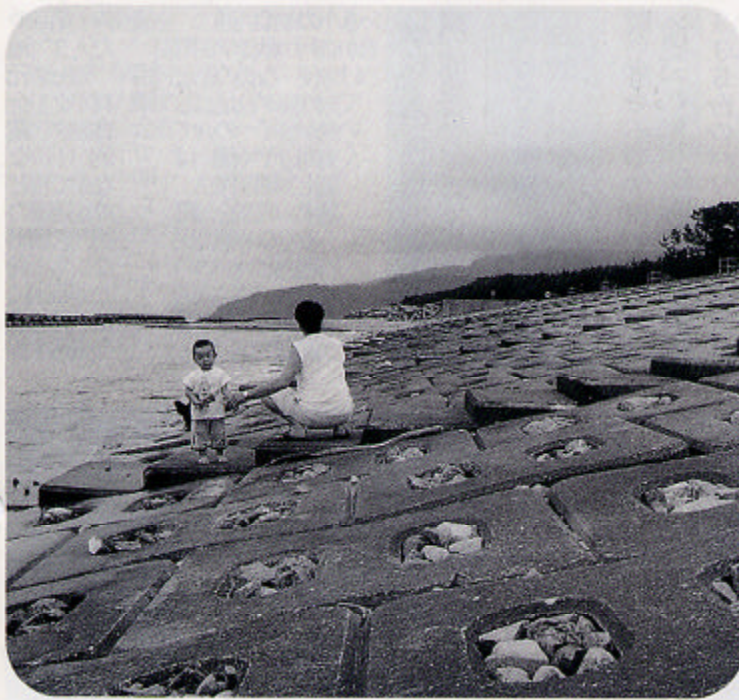
横山海岸の緩傾斜堤
