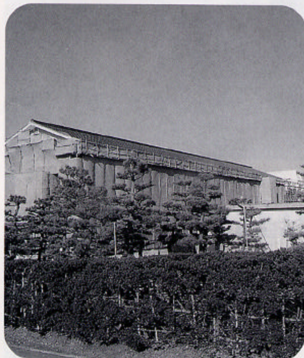
耐震工事中の入善西中学校
