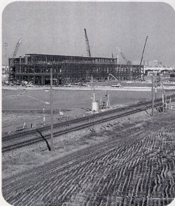
建設が進む(株)サンリッツ
