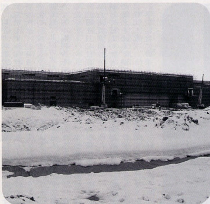
着々と建設が進むサンリッツの工場
