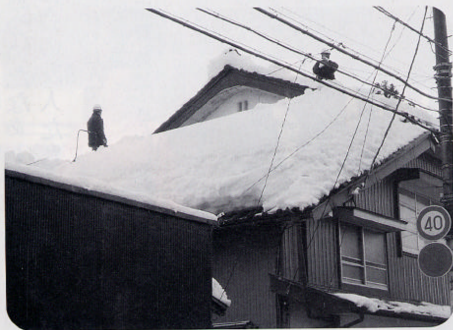
屋根雪下ろしにおわれた「平成18年豪雪」
