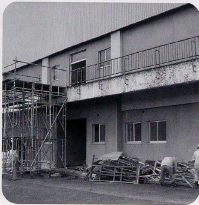
耐震工事中の黒東小体育館棟
