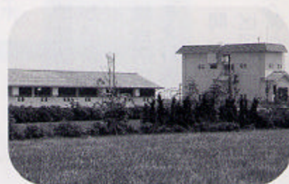
入善浄化センター
