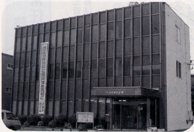
入善町商工会館
