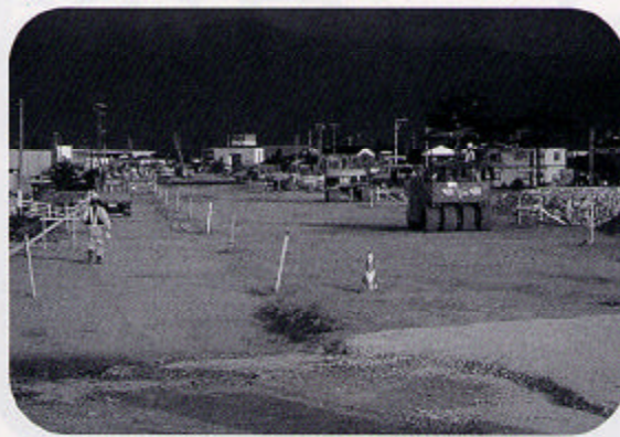
工事が進む8号線バイパス
