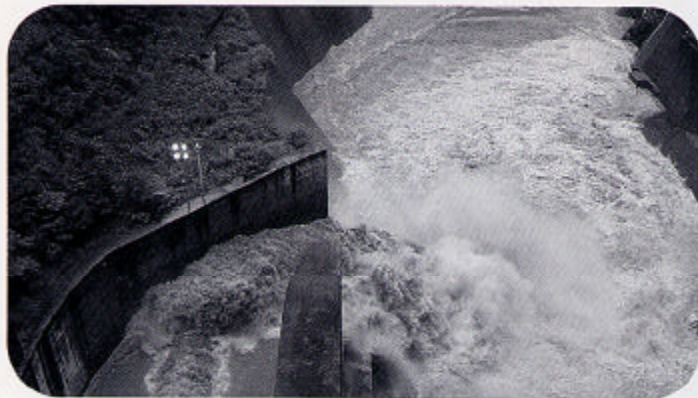
排砂中の宇奈月ダム
