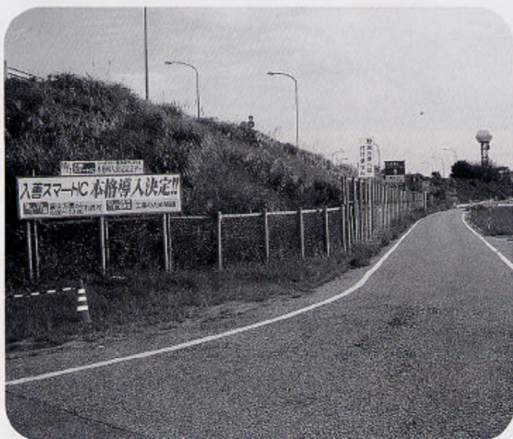
12月から本格工事（南側進入路）
