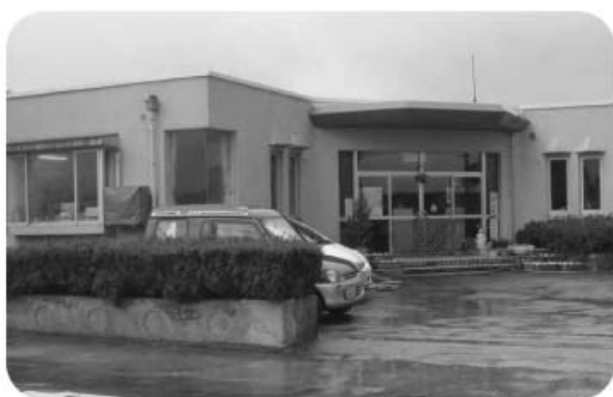
内装が補修される上原保育所
