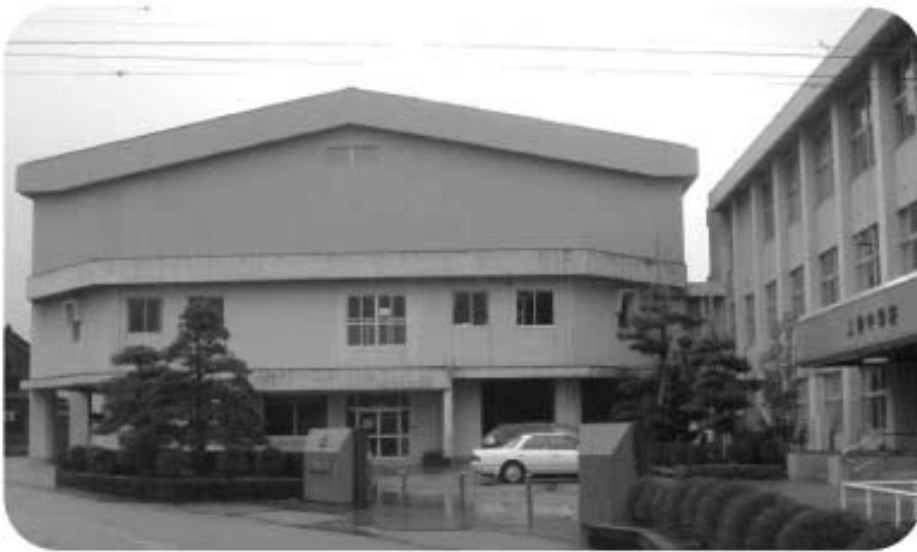
改修される入善中学校体育館
