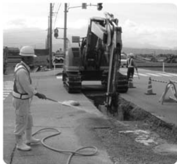
整備が進む下水道工事
