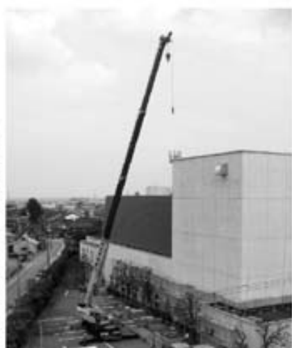
コスモホールの外壁改修
