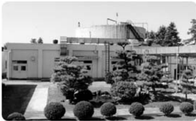
新施設の建設が待たれる中部清掃センター
