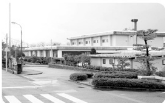
耐震改修工事が待たれる農村環境改善センター（飯野）
