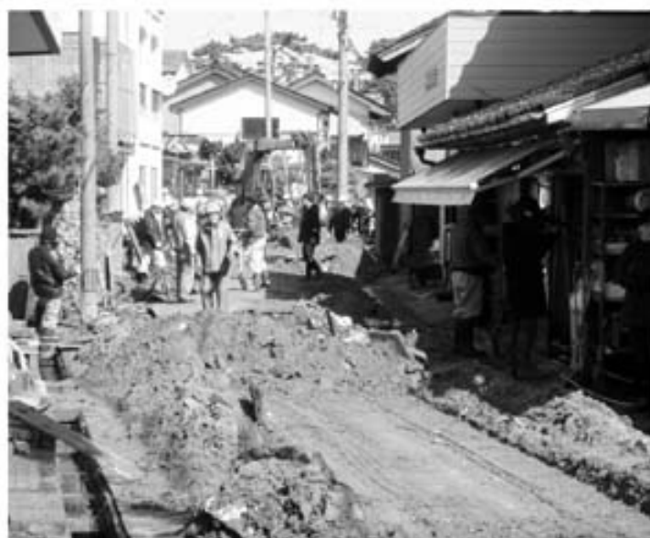
道路に堆積した大量の土砂
