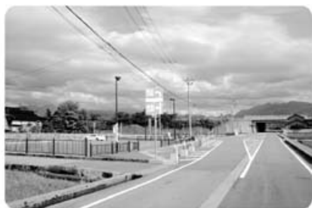
スマートICへの進入路附近
