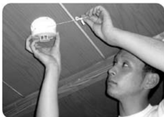
設置が義務付けられた火災警報器
