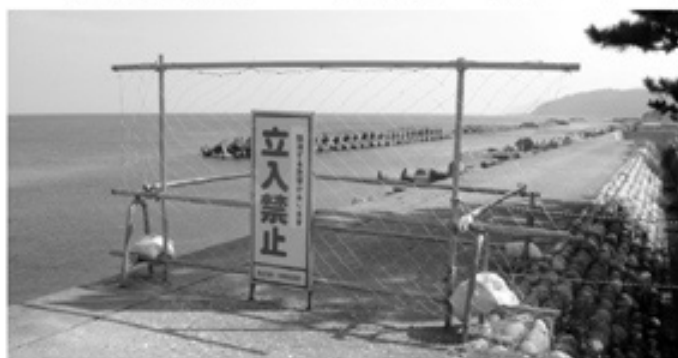
バリケードが設置された海岸堤防
