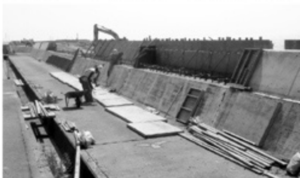
堤防のかさ上げ工事
