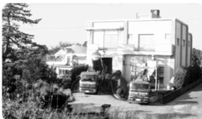
新し尿処理施設の建設着工が待たれる中部清掃センター
