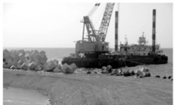
積み上げられる50トブロック
