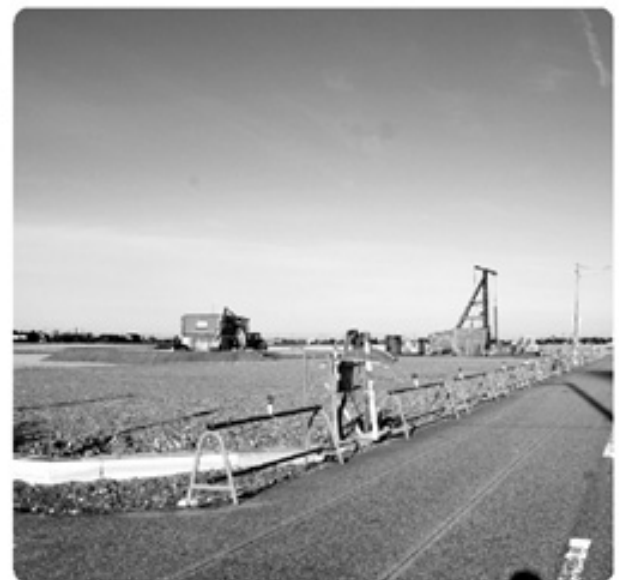
新工場の建設予定地（青木地内）
