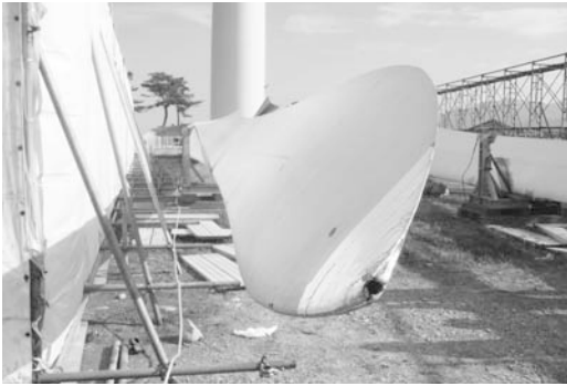
風車ブレード先端部分に落雷被害
