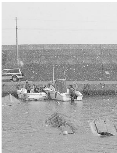
越波被害を受けた漁港内
