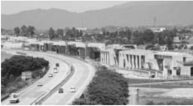
建設中の仮称「新黒部駅」周辺
