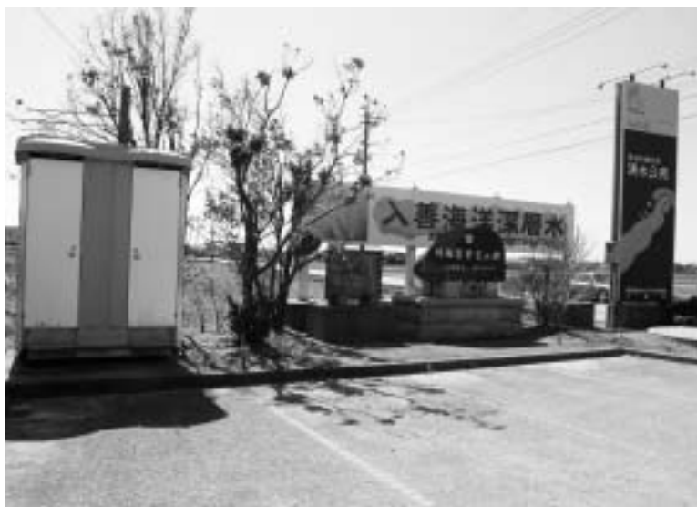
改修予定 湧水公園内のトイレ
