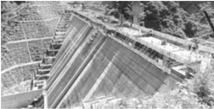
順調に建設が進む舟川ダム
