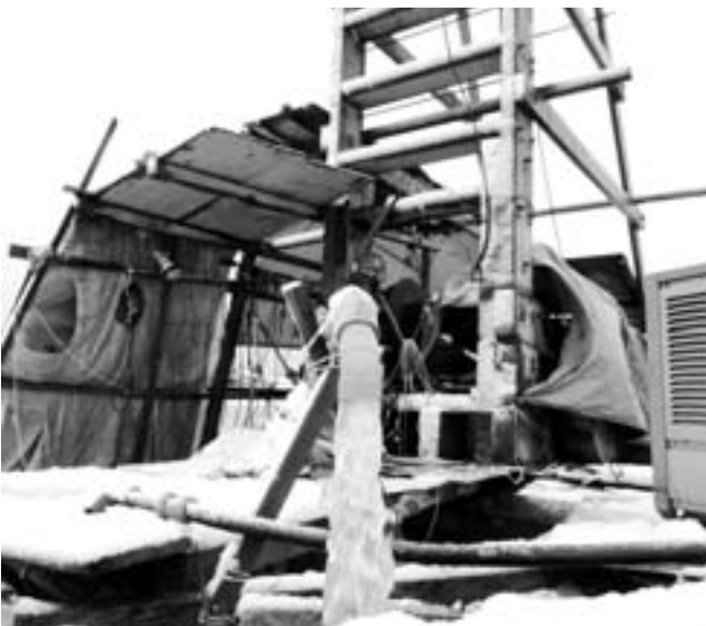
井戸掘りの現場
