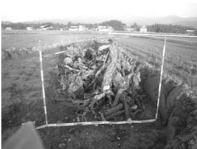
田の陥没現場から掘り出された樹根など
