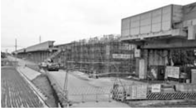
26年度中開業に向けた新幹線工事
