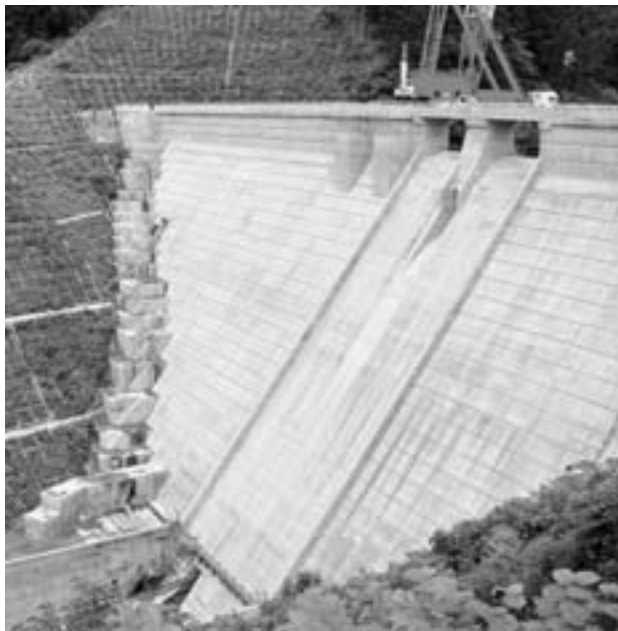
完成間近かの舟川ダム
