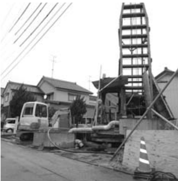
消雪設備のリニューアル工事
