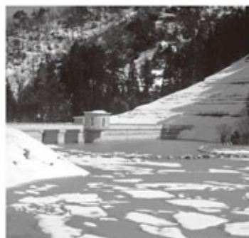
完成まじかの舟川ダム
