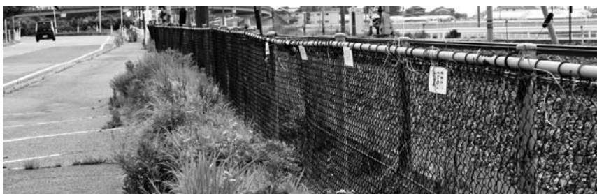
改修される駅南住宅駐車場のフェンス
