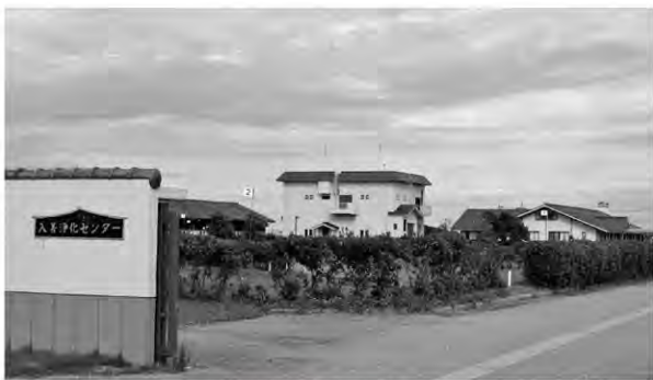
入善浄化センター
