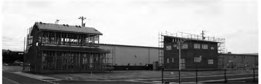
着々と進む住宅建設
