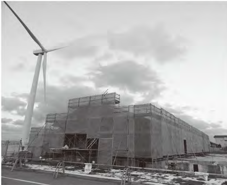
増築工事中の入善浄化センター
