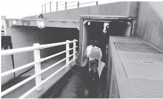
照明が取り付けられた横断地下道
