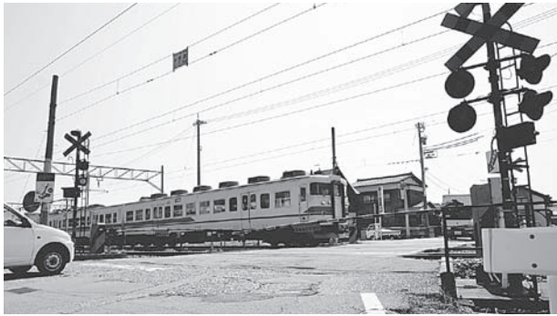
拡幅の待たれる踏切 (田中)
