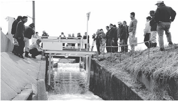
上掛け水車による発電実験（道俣用水）
