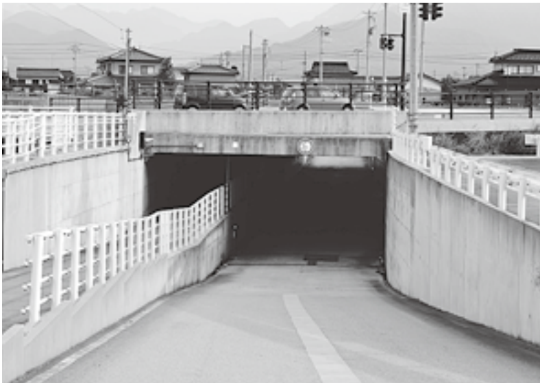
冠水時は通行禁止（8号バイパス下の町道）
