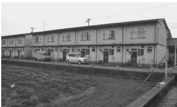
改築が待たれる町営住宅
