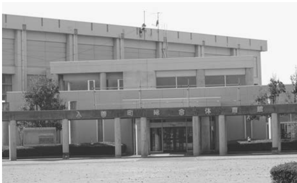
老朽化が進む総合体育館
