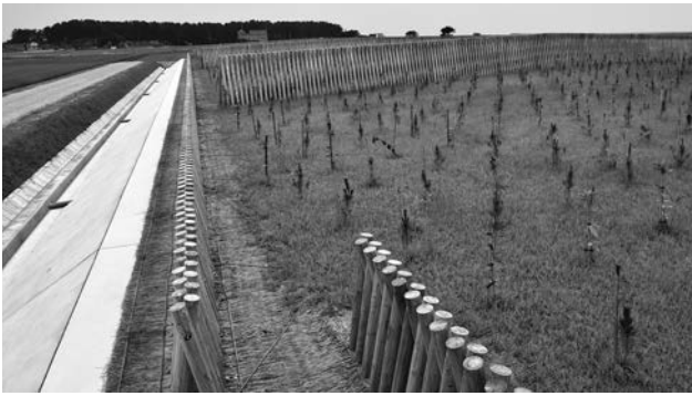
海岸防災林（下飯野地内）
