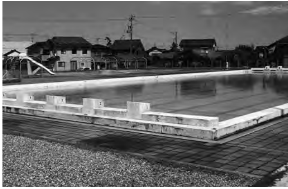
老朽化した中央プール
