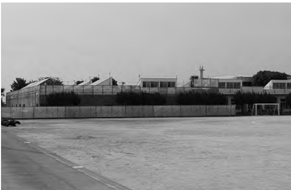
大規模改造中の上青小学校
