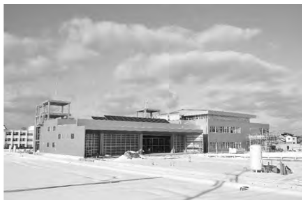
完成まじかの消防防災センター
