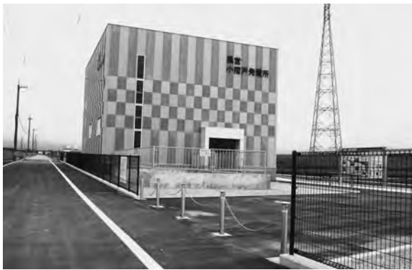
県営の小水力発電「小摺戸発電所」
