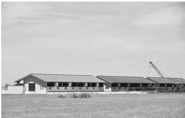
入善浄化センター
