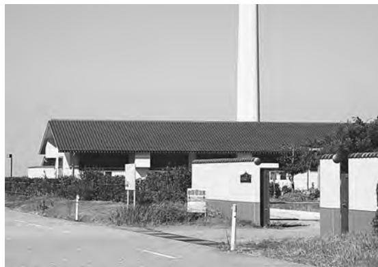
入善浄化センター
