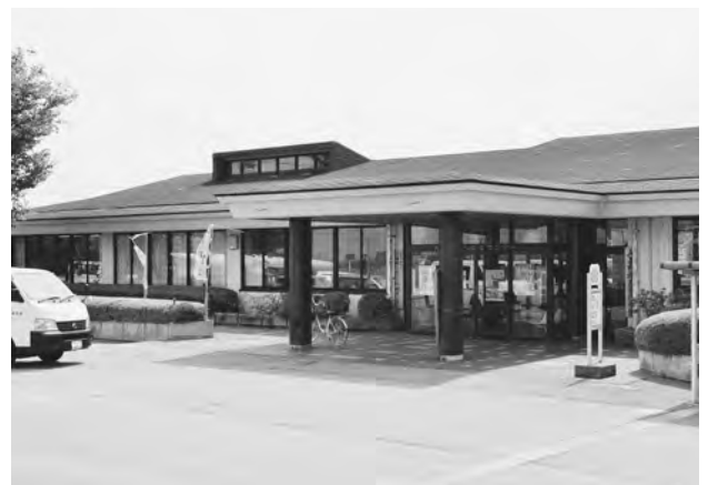
強風で被害を受けた老人福祉センター
