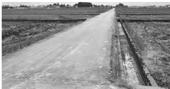
昨年、多面的機能支払支援事業で整備された農道
