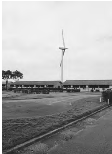
長寿命化工事を行う浄化センター
