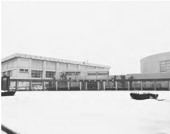
大規模改造される総合体育館
