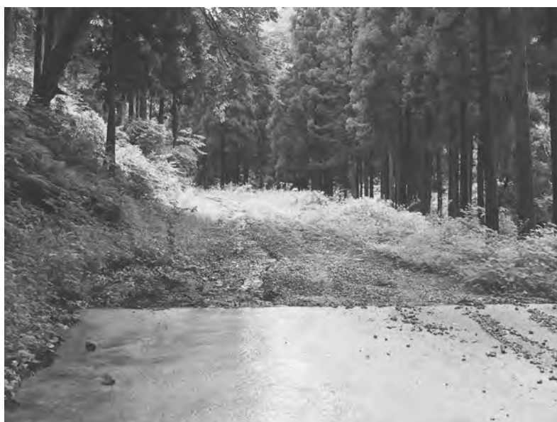
工事予定の林道中谷線
