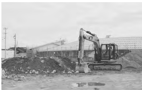
建設中の統合保育所
