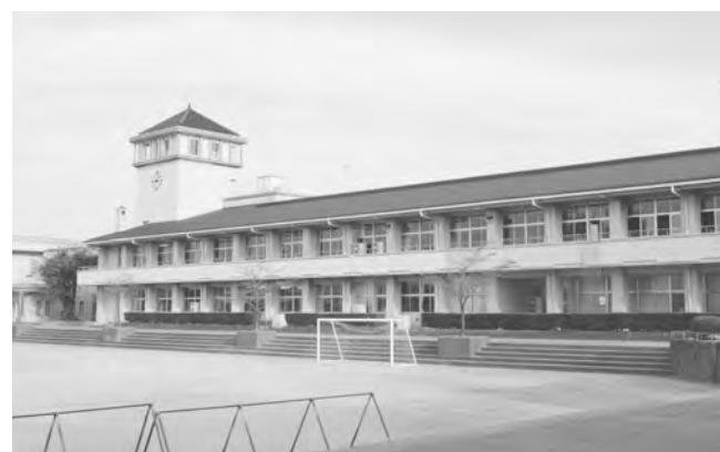
老朽化し改修が必要な入善小学校
