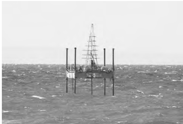
横山沖でボーリング調査
