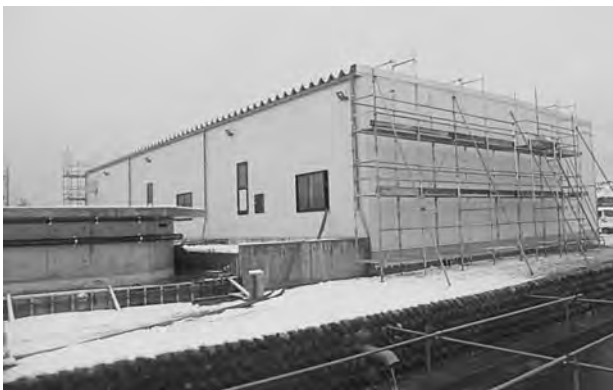
建設中の鮎の中間育成施設
