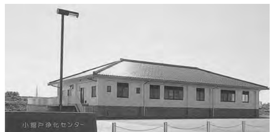
統廃合予定の小摺戸浄化センター
