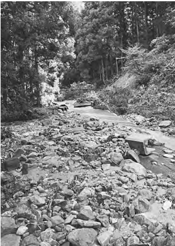
山肌が崩落し不通になった林道（舟見小川線）
