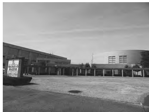
改修が進む総合体育館
