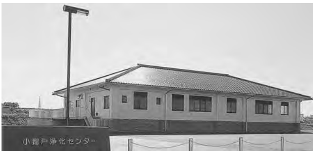
小摺戸浄化センター
